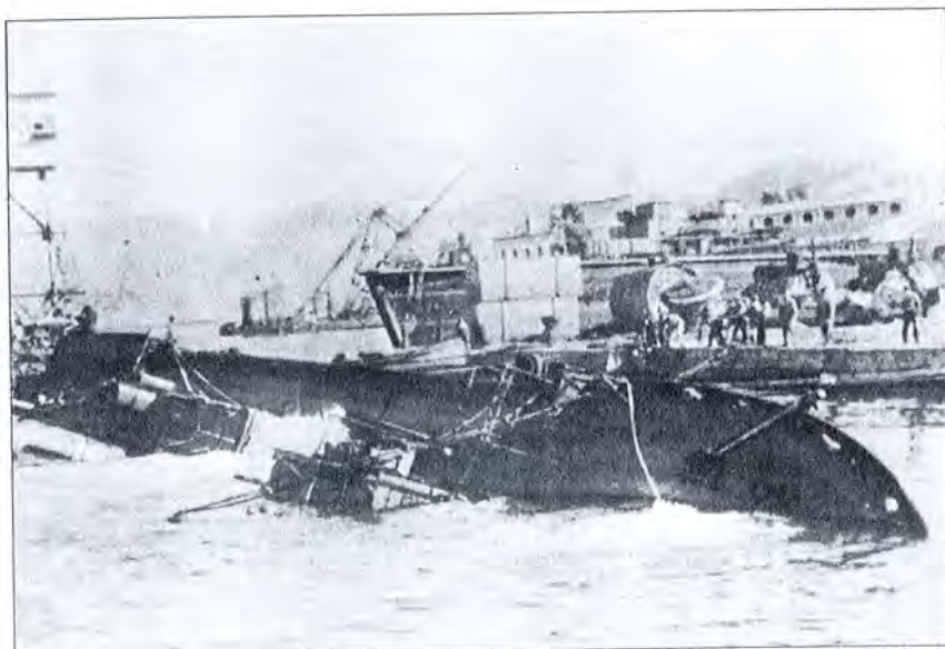
Salvamento del Aljibe n.º 3. Se utilizó aire comprimido. Arsenal de Cartagena
